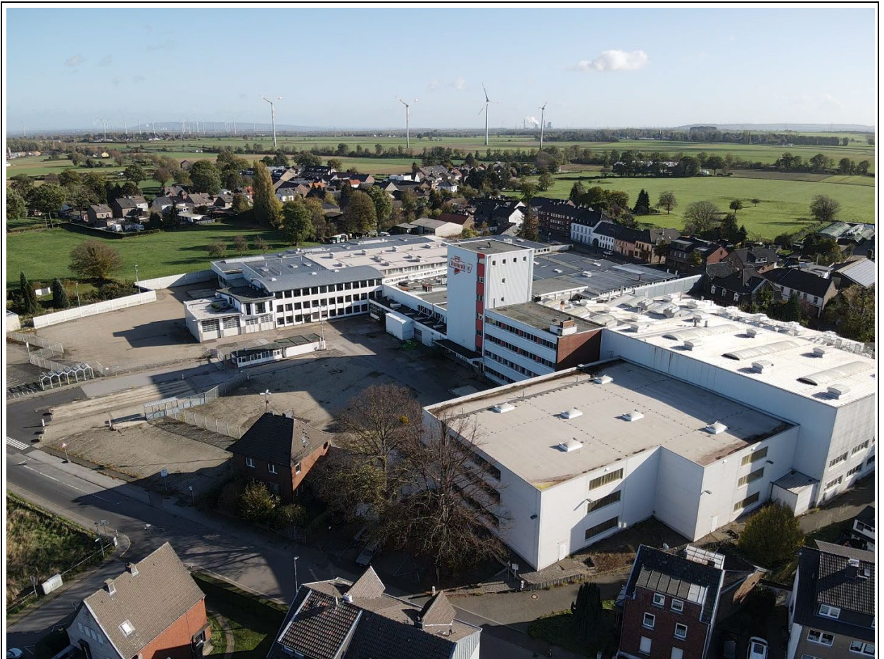
Luftbild 2023 – nach Betriebsaufgabe vor dem Rückbau
