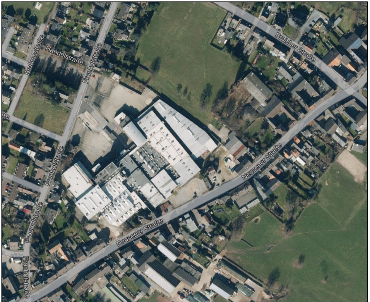
Abbildung 2: Luftbild 2022 vor Abriss der Gebäude Quelle: TIM online
