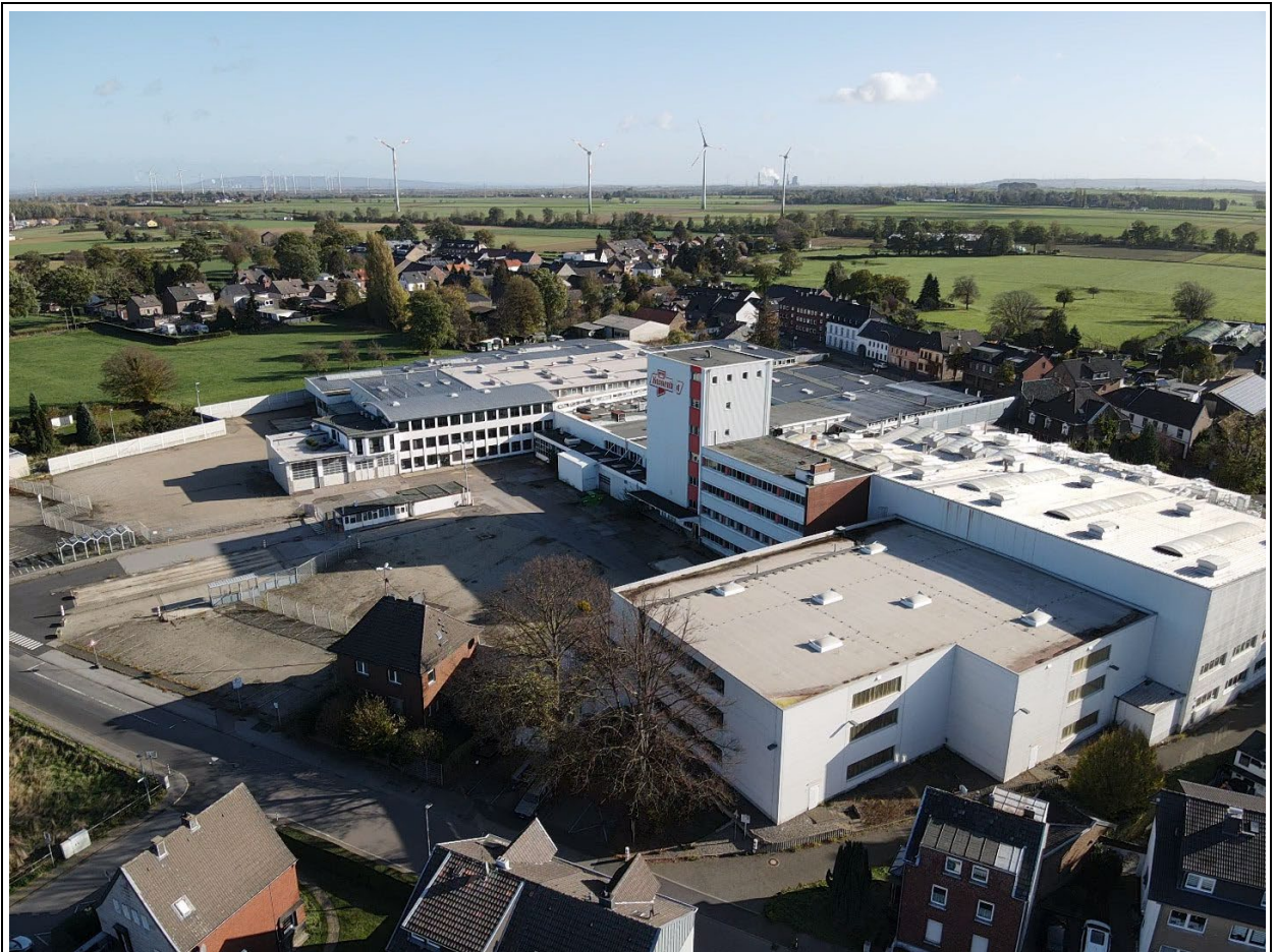
Luftbild 2023 – nach Betriebsaufgabe vor dem Rückbau
