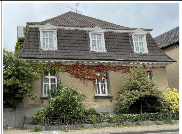
Villa Neusener Straße
