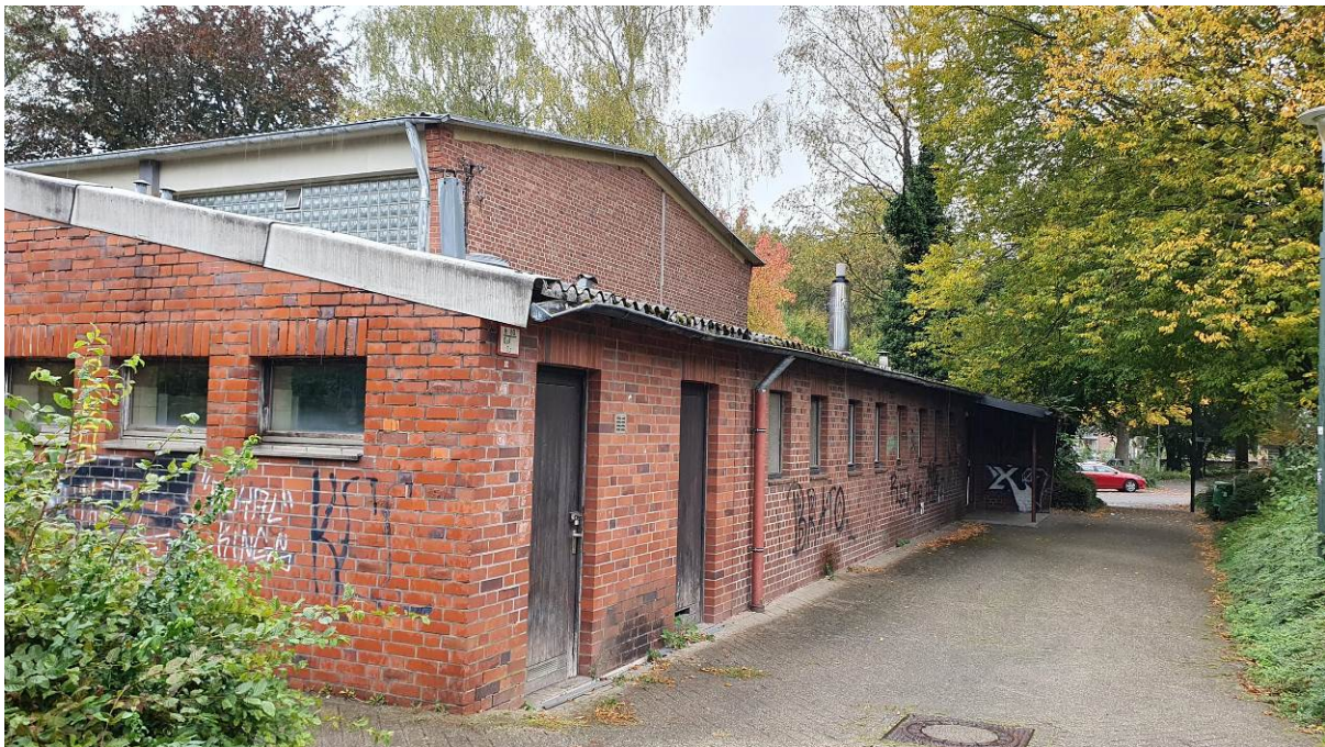
Abb. 8: Mehrzweck-/Turnhalle im südlichen Plangebiet (Teilbereich A), Blick von Süden (Foto 09.10.2024).
