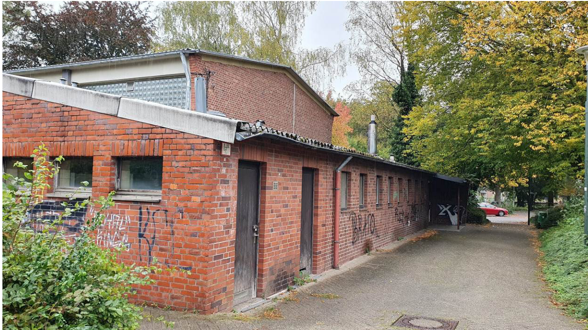
Abb. 9: Mehrzweck-/Turnhalle im südlichen Plangebiet (Teilbereich A), Blick von Süden (Foto 09.10.2024).
